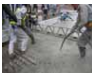
ポンプ圧送による打設 (バックホーのバケット流し込みも)
