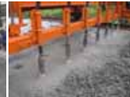
棒状バイブレータによる締固め
